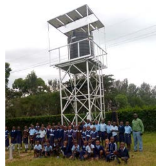
Hochbehälter der Schule Lwandanyi
